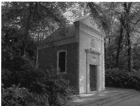
De Sint-Bonifatiuskapel na de restauratie.
